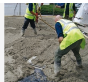
Surfaces en dur extérieures
