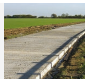
Fahrbahnen und Gehsteige
