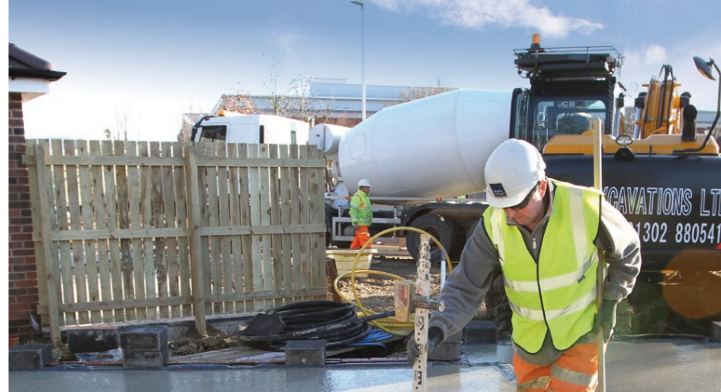
Boven: Plastische krimpscheuren gemeten d.m.v. een digitale microscoop Onder: Uitvoering van een druklaag met Durus EasyFinish wapening
